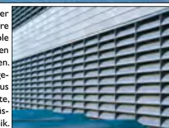
Grauton vorgegeben, der dann speziell für dieses Objekt entwickelt wurde. Diese vorgehängte, wärmegeämmte und hinterlüftete Fassade dient, neben der Optik im Wesentlichen dem zusätzlichen Wärmeschutz.
