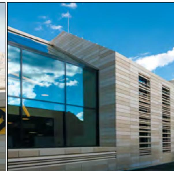
Die abgestuften Sandnuancen der Keramik-Elemente lehnen sich von der Tonalität her an die bestehende Bebauung an. Zur optimalen Umsetzung wurden speziell für dieses Projekt Sonderfarben und -formate gefertigt.
