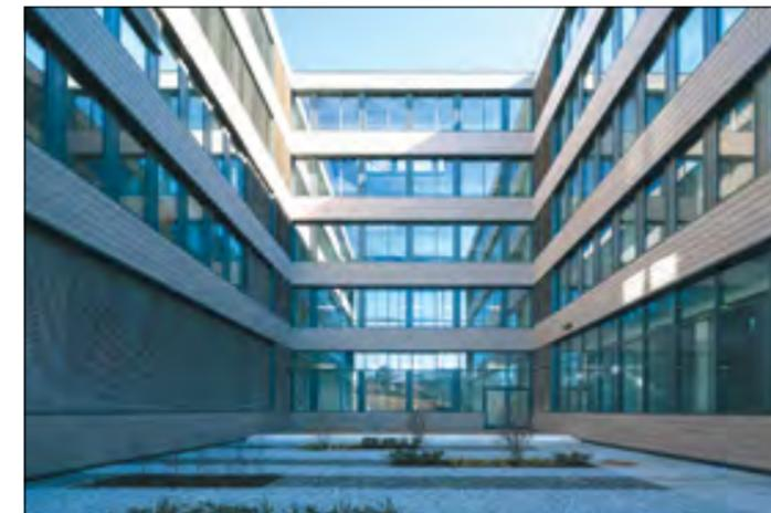
An den der Sonneneinstrahlung weniger ausgesetzten Flächen wurde das starre keramische Lamellensystem durch flexible Jalousien ersetzt, beispielsweise in den Innenhöfen. Das überwiegend auf der Ostseite eingesetzte starre Lamellensystem besteht aus dem gleichen Material wie die vorgehängte, wärmegeämmte Fassade an den Brüstungen, eine hell-graue Keramik.
