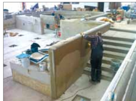
Bildreihe unten: Szenen einer Schwimmbad-Baustelle. Sorgfältige Ausführung und abgestimmte Produkt-Komponenten sind oberstes Gebot.
