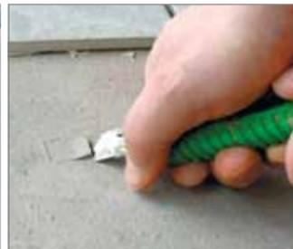
Funkenflug (links im oberen Drittel des Prüfbesens) statt Cuttermesser: Die Abdichtung bleibt bei der Hochspannungsprüfung unbeschädigt, bei der zerstörenden Prüfung muss anschließend ausgebessert werden.
