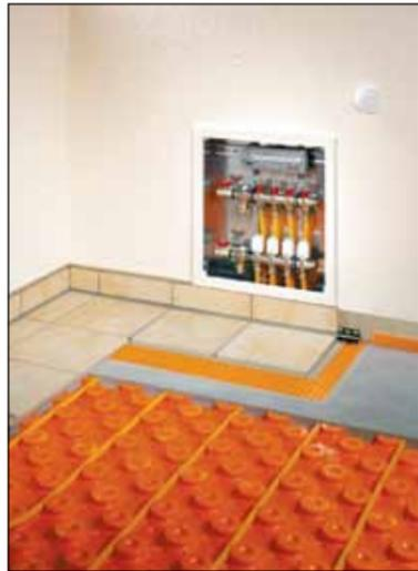
Das Foto zeigt den typischen Aufbau der geprüften Fußbodenheizung
