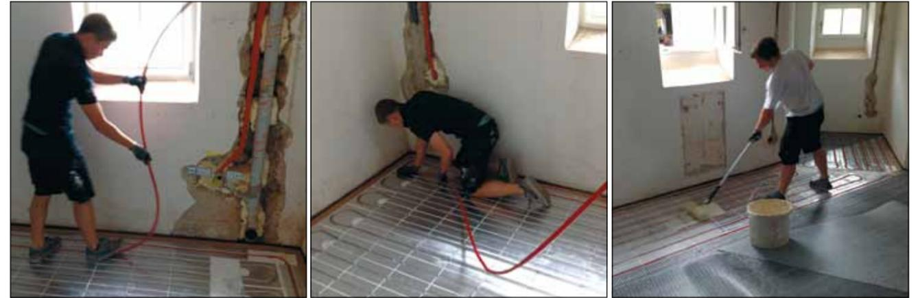
Nach der Egalisierung des Bodens mit Mehrschicht-Verbundplatten wurden die Rohrträgerplatten verlegt, in deren Kanäle die neuen Rohre eingedrückt werden. Oben rechts die Verklebung der Armierungs- und Entkopplungsmatte. Auf der Lastverteilungsplatte werden schließlich die Feinsteinzeugfliesen verklebt (rechts).
